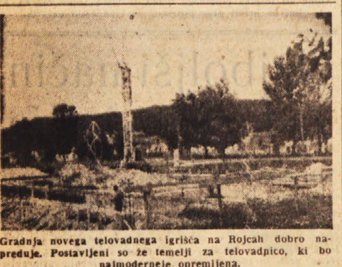
Gradnja novega telovadnega igrišča na Rojčah dobro napreduje. Postavljeni so že temelji za telovadnico, ki bo najmoderneje opremljena.
