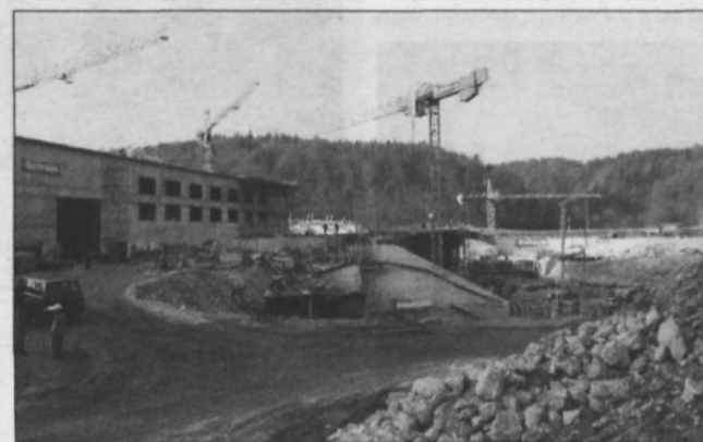
Gradbišče HE Blanca
