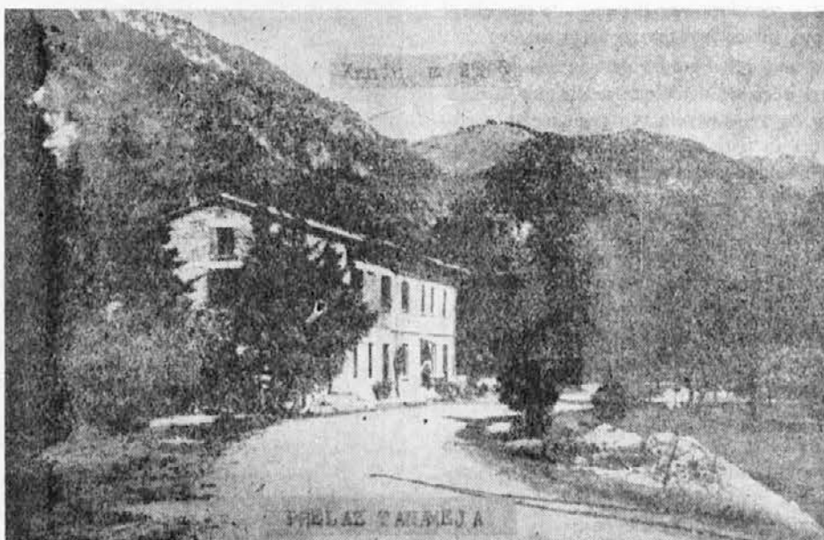
PRELAZ TAMNAMEJA, KJER BODO ZGRADILI MODEREN HOTEL
