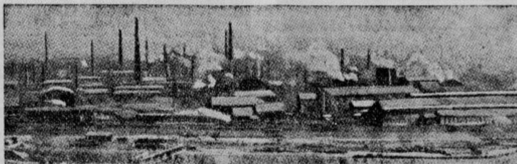
Pogled na industrijski del Saarbrückena, glavnega mesta Posaarja.
