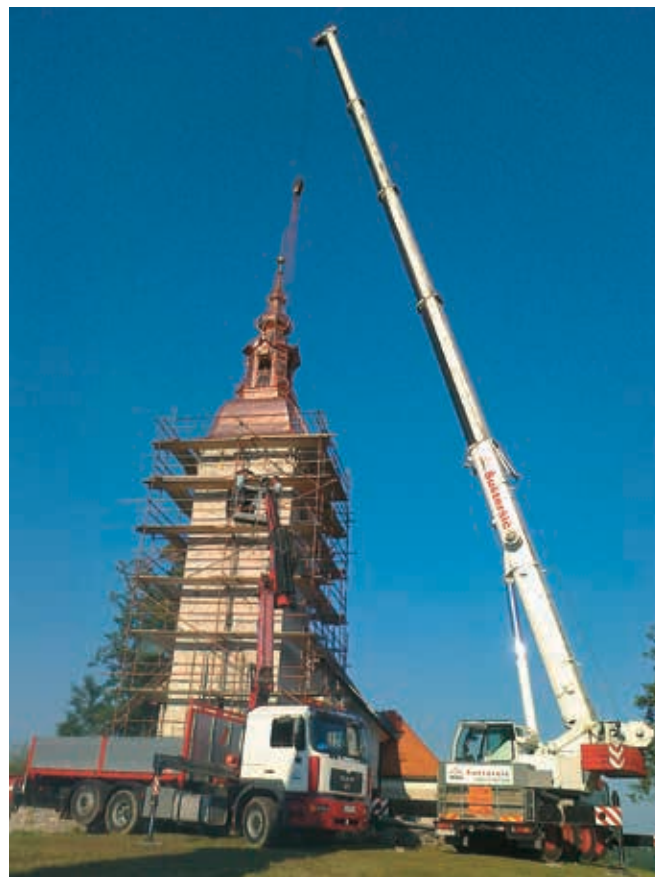
Postavljanje vršnega dela zvonika ob cerkvi sv. Martina v Setniku pri Polhovem Gradcu
