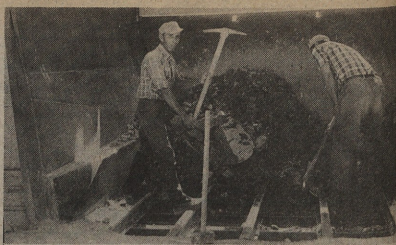
Delavec na rešetki: Slavko Božec in Franc Ceglar, razbijata večje skale pred primarnim drobljenjem
