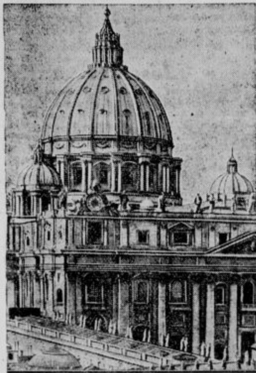
Kupola sv. Petra popravljena. Pred tremi leti so opazili na kupoli sv. Petra v Rimu velike razpoke. Papež je takoj odredil vse potrebne popravke, ki so jih sedaj dovršili. Velike kamene so nadomestili z novimi, razpoke so zalili z železobetonom. V spomin velikih poprav so vrezali v kamen ime sedanjega papeža in letnice.
