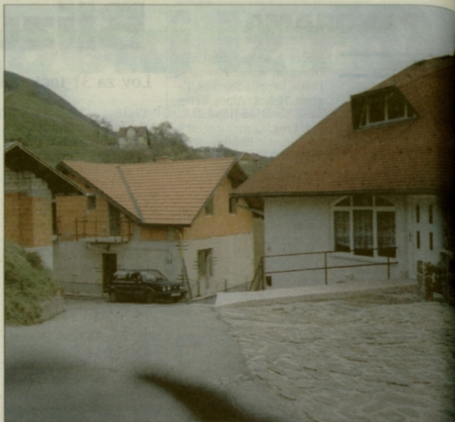
Na služnostni poti in dvorišču obenem. Vse se je začelo z dnem, ko je gospa Angela začela graditi na parceli, kjer ne bi smela in potem dobila vsa dovoljenja za gradnjo. Izvirni greh je na strani uradnikov, gašenje požara na strani sodnikov. Le zmagovalcev ni in jih v tej zgodbi najbrž tudi ne bo prav kmalu.
