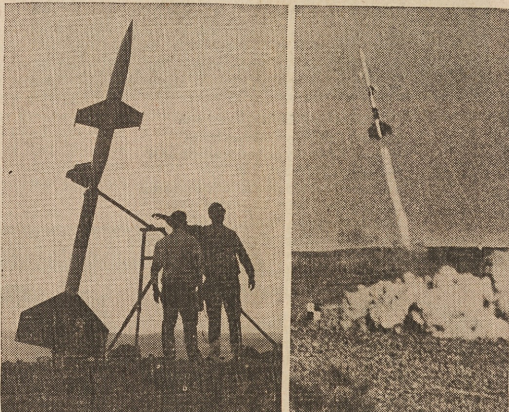
IZRAELSKA RAKETA — Izraelci preskušajo v puščavi Negov "Technion 1972" raketno letalo, ki doseže 1.18 mach brzine in se dvigne 3.7 milj visoko. Dolgo je komaj 7.3 čevljev in tehta le 280 funtov. Čemu naj bi to raketno letalo služilo, poročilo ne pove. Na levi ga vidimo na tleh pred vzstrelitvijo, na desni po vzletu, ko se pomožna raketa še ni ločila od letala.
