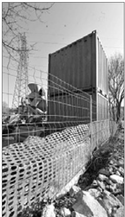
Ponekod so se dela že začela
