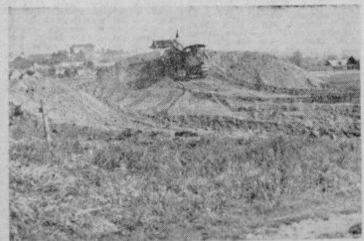
Buldozer »Agrotransport« planira teren za novo tovarno
