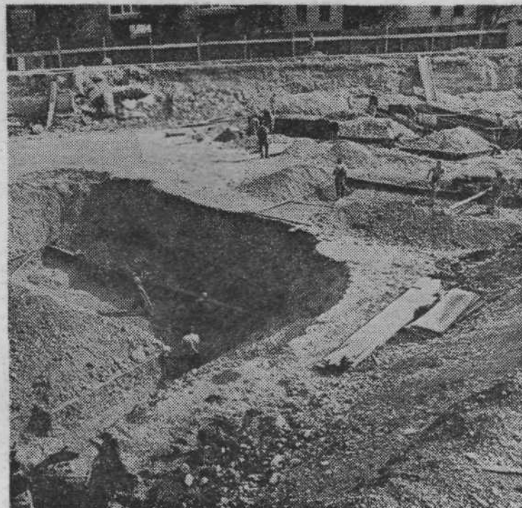
Temelji novega vrtca A. Zihrelove
