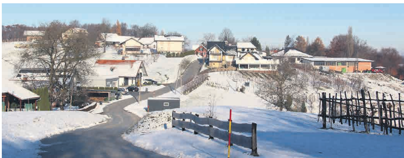
Občina Juršinci bo naslednje leto na Kukavi obnovila 350 metrov vodovoda, kjer se krajani neprestano srečujejo z okvarami na sistemu. Če bi šli v obnovo vsega vodovoda v občini, ki je v slabem stanju, bi potrebovali 10 milijonov evrov, je povedal župan Robert Horvat. Za obnovo so že pripravili dokumentacijo, pridobivajo služnosti in čakajo, kdaj bo na voljo kakšen razpis za evropska ali državna sredstva.
