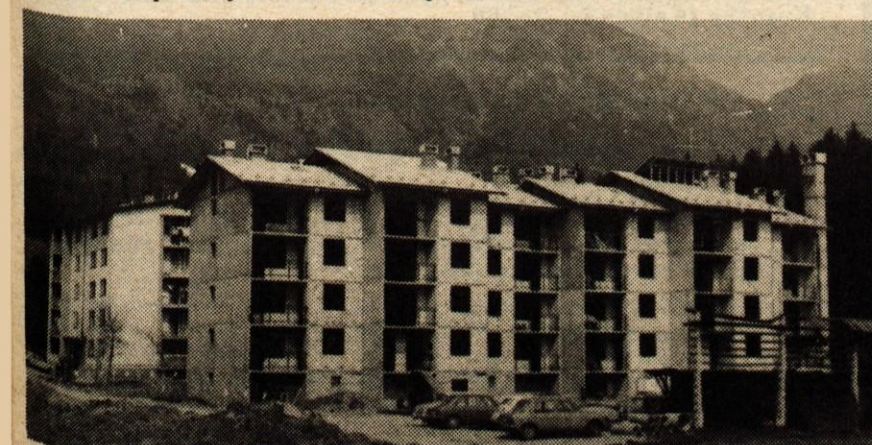
NA GOLNIKU GRADIJO — Delavci Splošnega gradbenega podjetja Projekt iz Kranja, TOZD Trzin, so začeli sredi lanskega leta graditi na Golniku nov stanovanjski blok, ki bo predvidoma vseljiv julija letos. V njem bo 44 enosobnih, dvosobnih in trosobnih stanovanj in garsonjer za delavce Golniške bolnišnice. (jk) — Foto: F. Perdan
