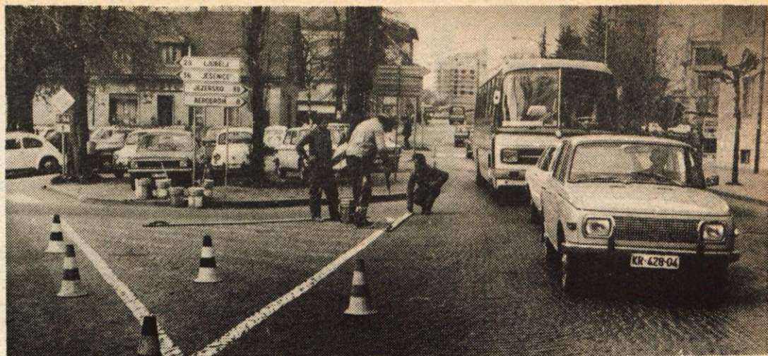
Po naročilu republiške skupnosti za ceste poskrbi Cestno podjetje iz Kranja vsako leto za tako imenovano talno cestnoprometno signalizacijo. V poštev prihajajo ceste, širše od petih metrov. Na fotografiji urejevanje signalizacije na križišču pri Bekselnu v Kranju. (jk) Foto: F. Perdan
