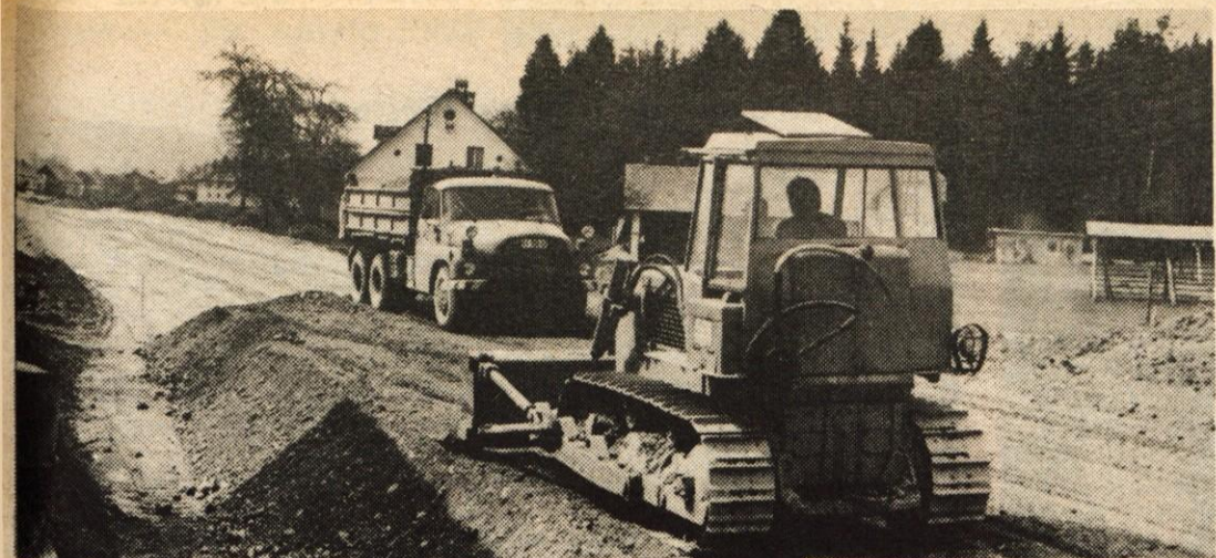
Cestno podjetje iz Kranja urejuje cesto med Godešičem in Retečami, dolgo 2,5 kilometra. Dela financira republiška skupnost za ceste. Cestno podjetje iz Kranja računa, da bo modernizacija pomembnega cestnega odseka končana julija letos. (jk) — Foto: F. Perdan
