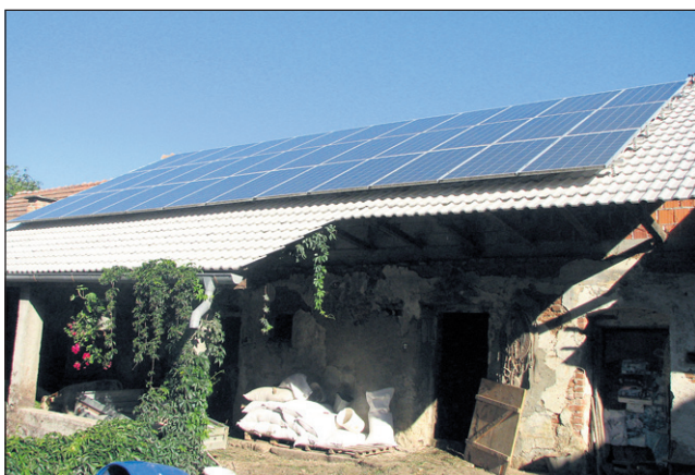
Na hlevu je položenih 36 panelov, ki letno dajejo 10.000 kW električne energije.
