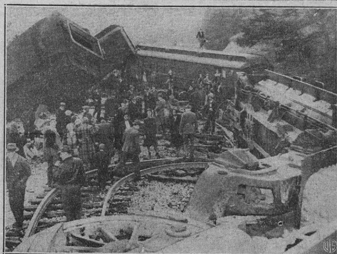
Železniška nesreča pri Chattanooga, Tenn. Dva železničarja sta bila ubita in več potnikov ranjenih. Poglejte skrvljenje tračnice, ki so se zvile kot slamnate bilke pritisku jeklenih vagonov.
