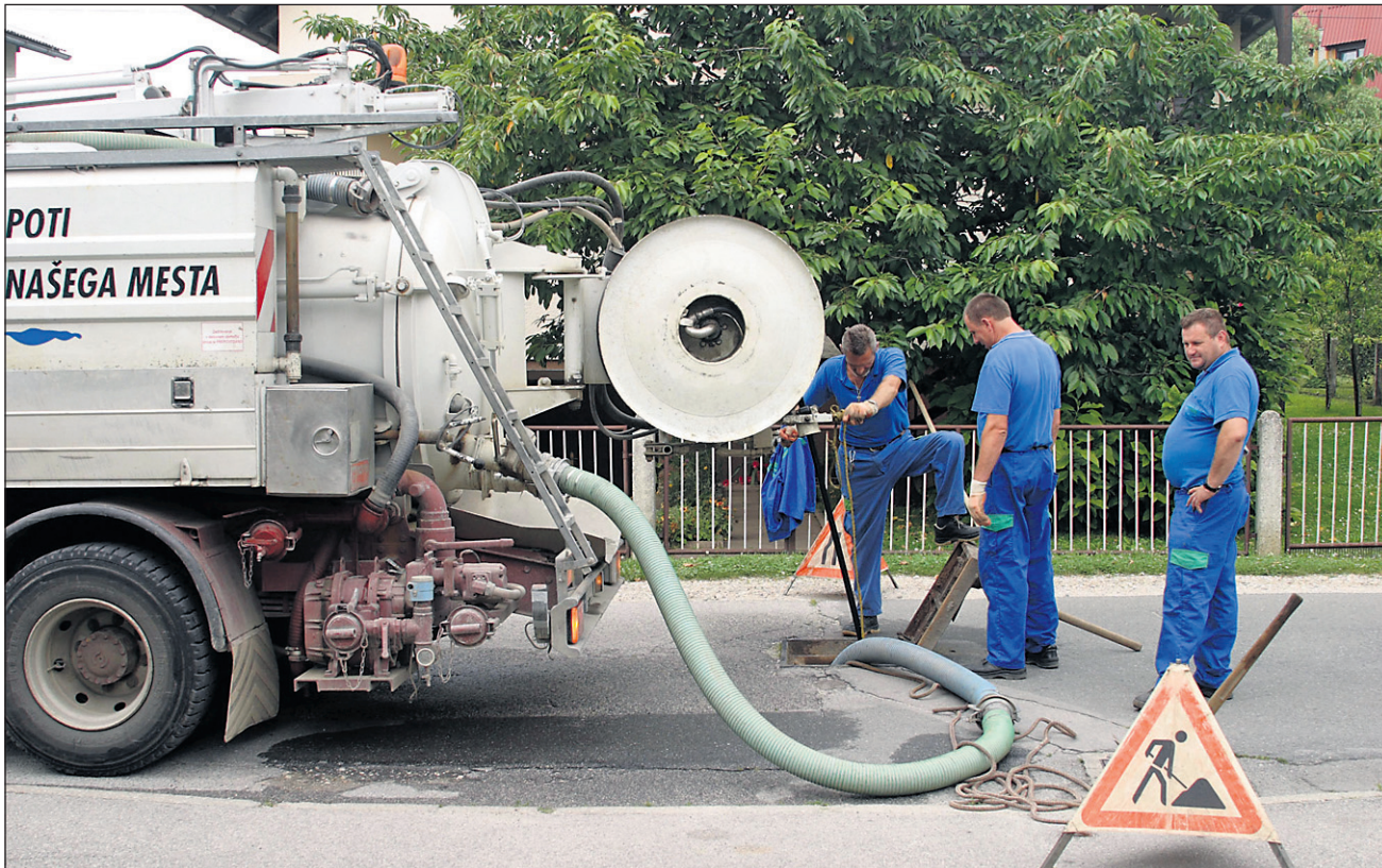
30. junija se je končno začel pregled kanalizacije. Bodo meritve pokazale to, kar so pokazale že pred desetimi leti?
