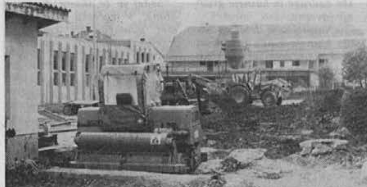
Gradbeni stroji so zahrumeli že pred dopustom in pripravili vse potrebno za asfaltiranje
