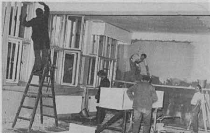
Takole se je začela obnova garderob za montažne oddelke
