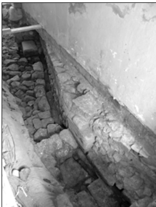
Slika 11. Romanska faza vhoda: kamnit tlak z muldo, stena porušenega objekta, obodni zid s portalom in prag v tlaku, pogled proti jugozahodu (foto: M. Lavrič).
