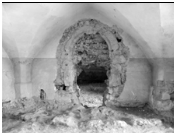
Slika 4. Portal v južni steni severozahodnega stolpa s kamnito substrukcijo (foto: M. Bricelj).
