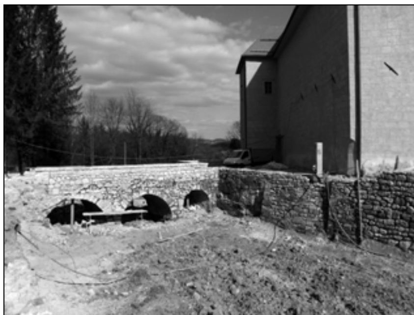
Slika 15. Jugozaahodni del jarka z mostom in parapetnima zidovoma (foto: M. Lavrič).
