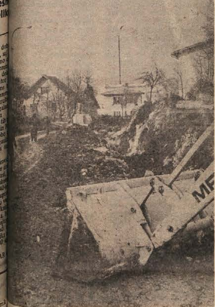
21. oktobra v Črnomlju je že nekaj časa zaprta za ves pro-cesi pa se še prebija po njej, čeprav je cesta prekopana in njej stroji. Gre za eno večjih komunalnih del: modernizacijo ceste tja do Ručetne vasi, kasneje pa še do Črmošnjice (Foto: R. Bačer)
