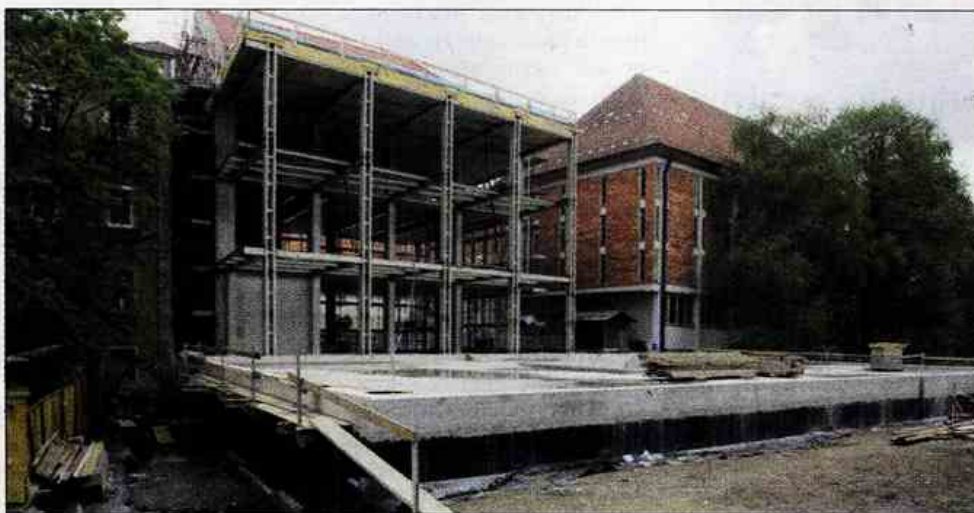
Ena večjih celjskih naložb je prizidek h knjižnici.
