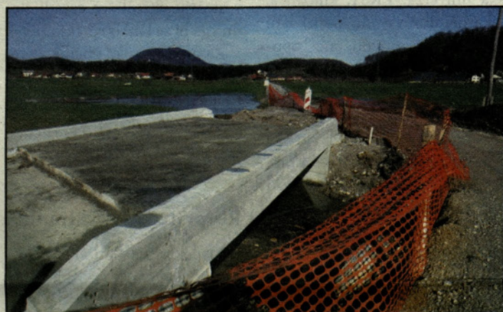
Gradnja novega mostu
