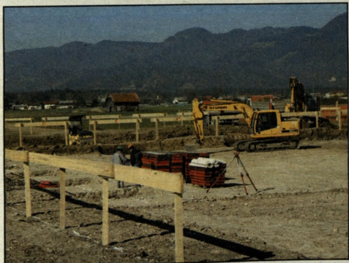
Začetek zemeljskih del
