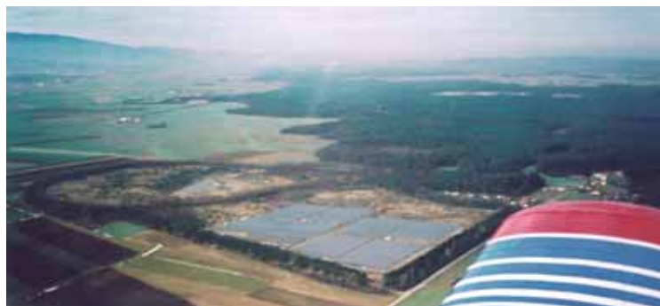
Pogled iz zraka na največje fotovoltaično polje v Sloveniji (4 MW moči)
