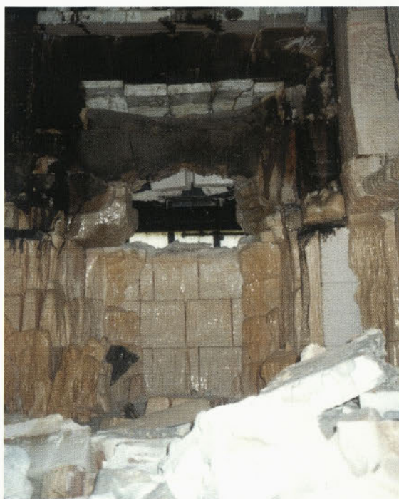
Ostanki iste peči po izpustu stekla.
