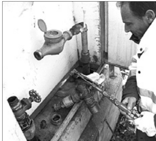
Merilec vetra pri Ajdovščini (zgoraj); inštalater popravlja vodomerni števec, ki mu je bil mraz usoden (desno)
