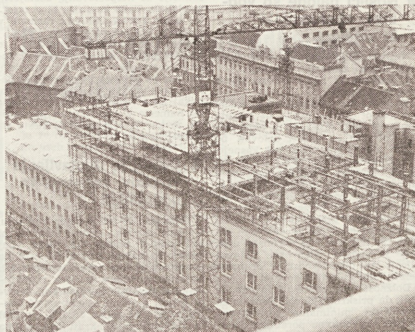
V središču Ljubljane je ponovno oživel naše gradbišče. Tokrat za hotel Slon izvajamo nadzidavo in adaptacijo
