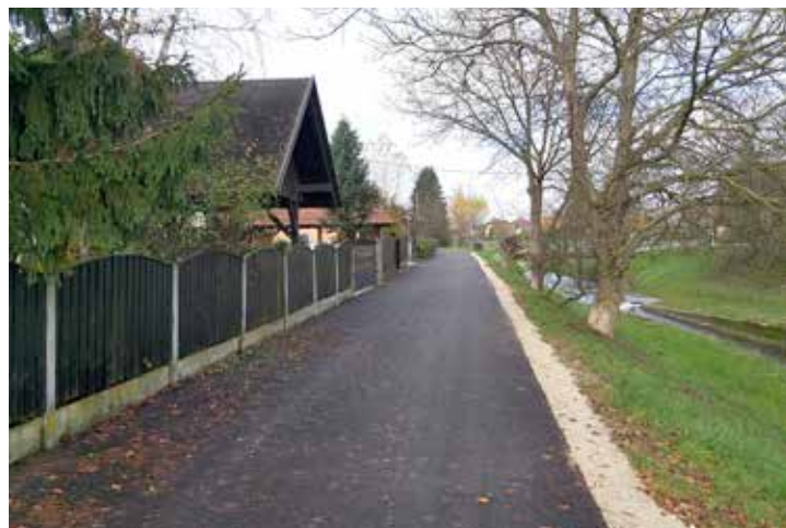
Z opravljeno rekonstrukcijo ceste se je izboljšala kakovost bivanja stanovalcev ob obnovljeni cesti, ki živijo v neposredni bližini struge Pšate. Na celotni dolžini ceste je bil zamenjan vodovod s hišnimi priključki ter opravljen pregled stanja kanalizacijskega omrežja in opravljena točkovna sanacija.
