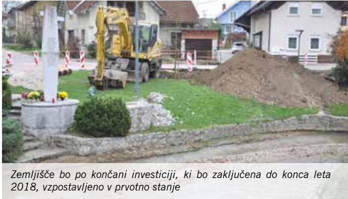
Investicijsko vzdrževalna dela na kanalizacijskem črpališču pri spomeniku v Loki pri Mengšu je bilo potrebno izvesti zaradi vse večje količine pretoka odpadnih vod, ki jih staro črpališče ni uspelo optimalno prečrpati.
