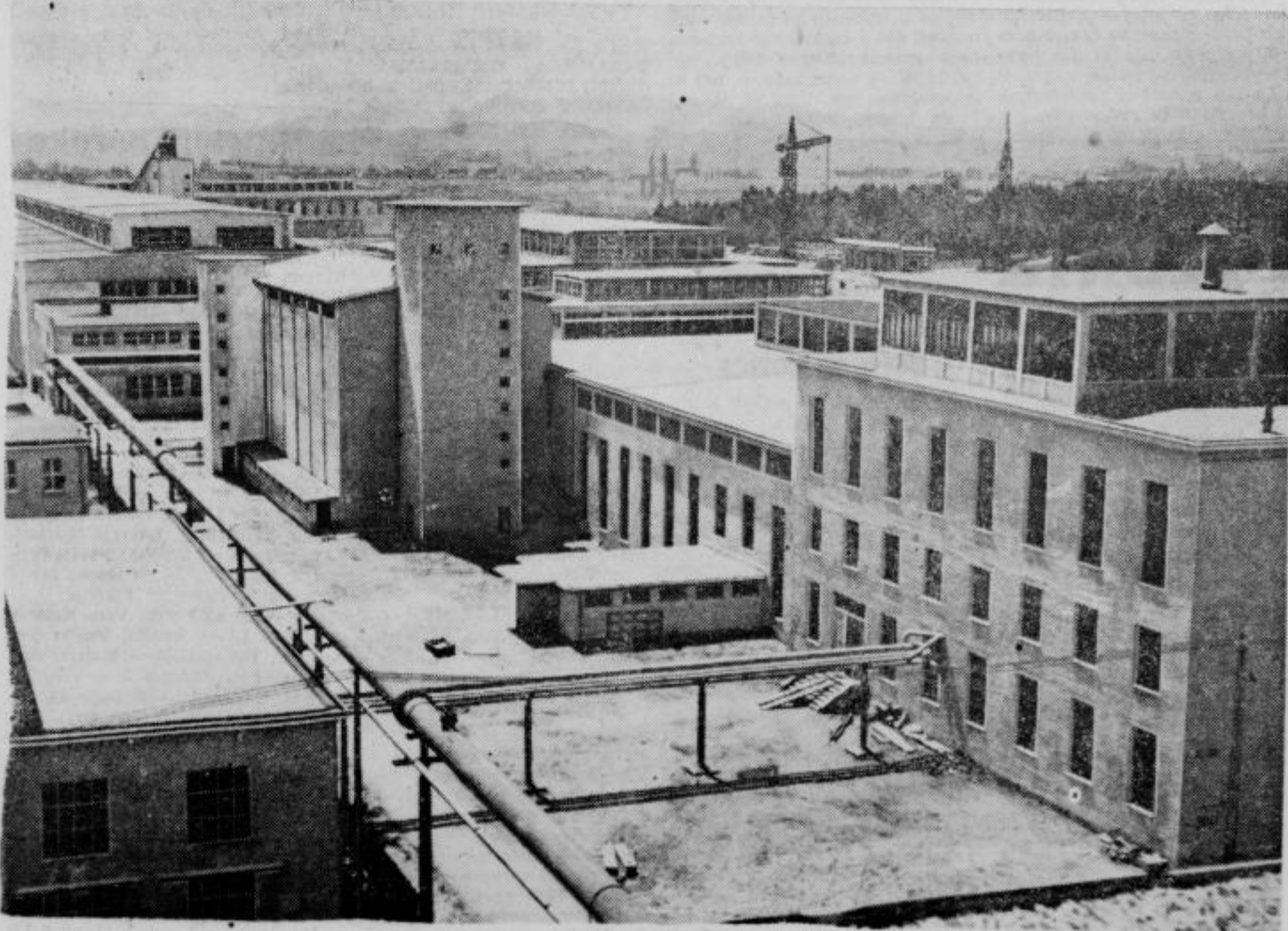
Pogled na delovniški kompleks
