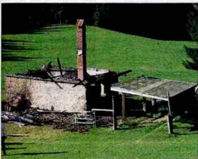
Od pastirske koče so ostale le zidane stene in dimnik.
