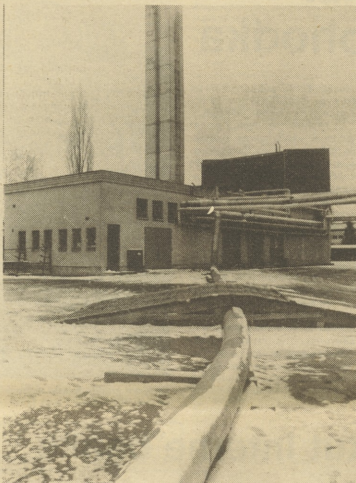
Posnetka cevodovodov, ki so jih Bliskovi monterji popravili v Muri.
