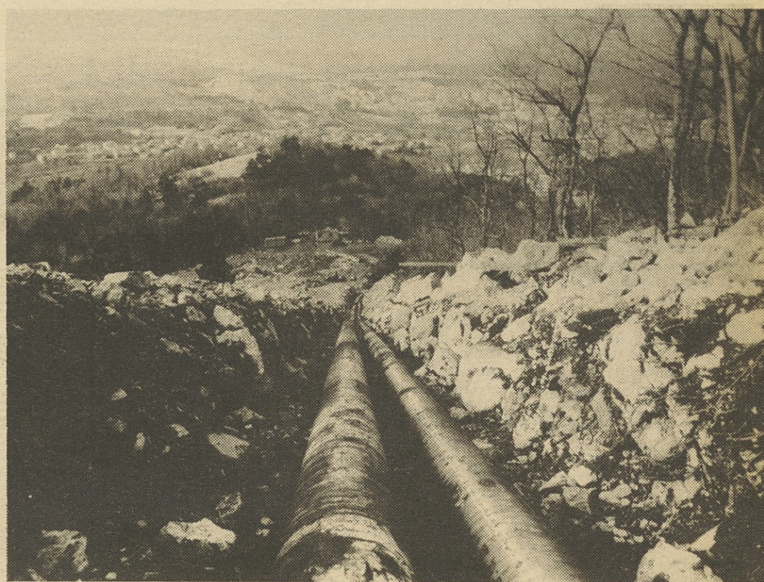
Ovečevci gradijo Kraški vodovod. Na sliki: cevovoda s premerom 500 in 400 milimetrov za rezervoar pri Sežani. Reportažo s tega gradbišča preberite na 4. strani!
