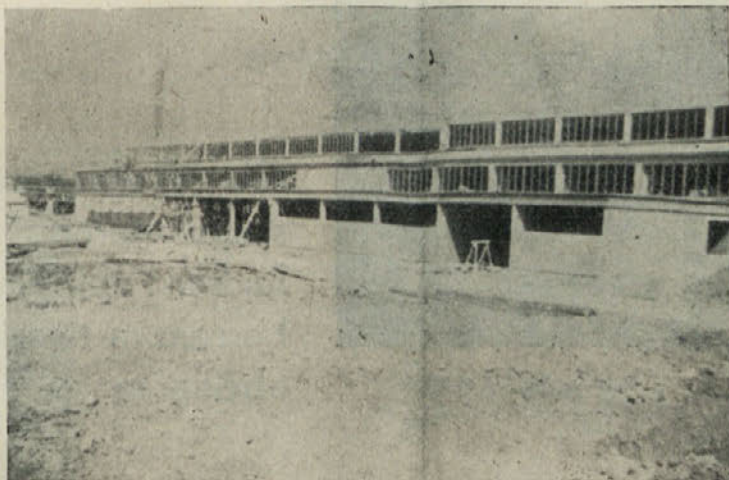
Gradnja Kemične tovarne v Kočevju lepo napreduje
