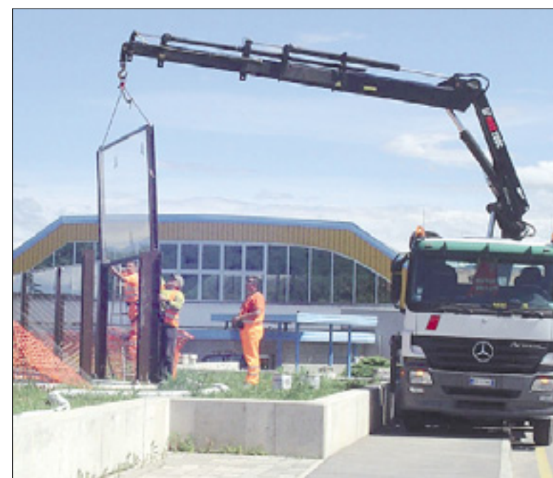
Nameščanje steklenih protihrupnih pregrad
