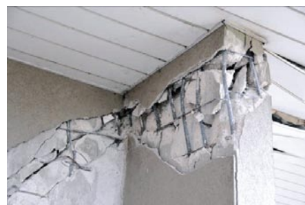
Slika 6b • Neduktilni konstrukcijski detajli armature v steni
