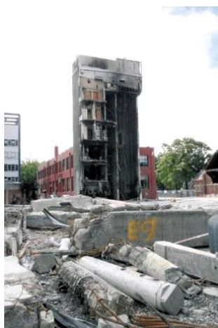
Slika 15 • Popolna porušitev stavbe televizije Canterbury. Med glavnimi vzroki za porušitev je bil slab stik etažnih plošč z jedrom. (Vir: Ken Elwood)
