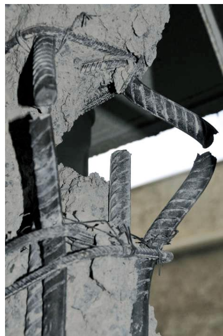
Slika 10b • Značilen pretrg vogalne navpične armature zaradi posledja plastifikacije in uklona
