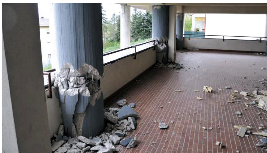
Slika 5 • Strižna porušitev stebra ob togem parapetu/ogradi
