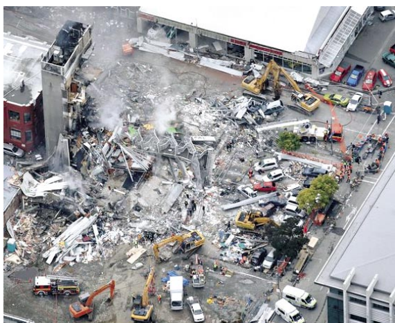
Slika 15 • Popolna porušitev stavbe televizije Canterbury. Med glavnimi vzroki za porušitev je bil slab stik etažnih plošč z jedrom. (Vir: Ken Elwood)
