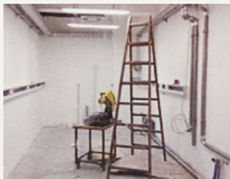
Zaključevanje obrtniških del
