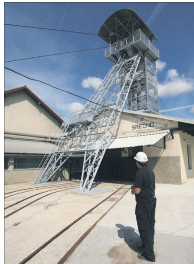
V globino 157 metrov se popeljemo z najstarejšim delujočim dvigalom v Sloveniji, ki je iz leta 1888, torej je tudi stari rudniški stolp eden najstarejših pri nas. Zgrajen je bil v enakem času kot Eifflov stolp v Parizu, zato ga včasih tudi enako poimenujejo.
