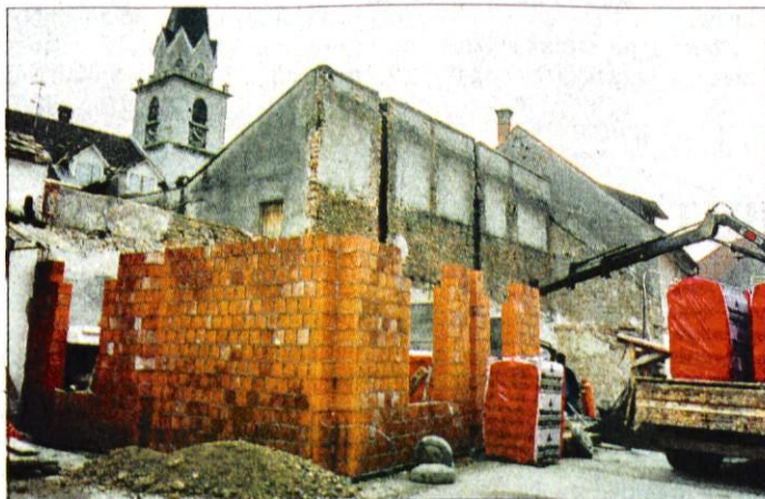
Štiri faze Tomšičeve 21: 1. stara hiša, 2. rušenje do ostanka skeleta, 3. popolno rušenje in 4. začetek nove gradnje.
