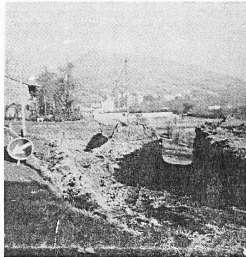
Začeli so kopati za cesto pod Škrutovem.
