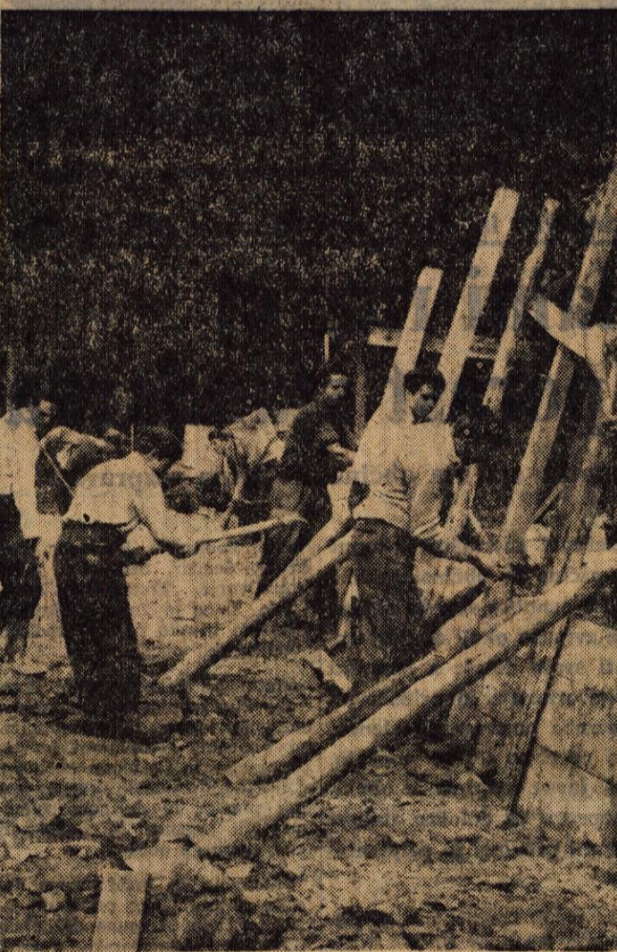
Podjetje »Hudournik« iz Ljubljane urejuje cesto iz Jesenic do Planine pod Golico. Speljali so več ovinkov in zgradili škarpe in jezove, da bo cesta lažje prevozna.
