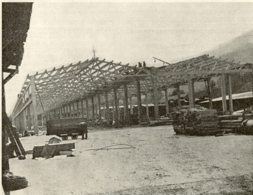
Gradnja nove vratarne v Borovnici
