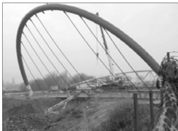
Dela na loku novega jeklenega mostu
