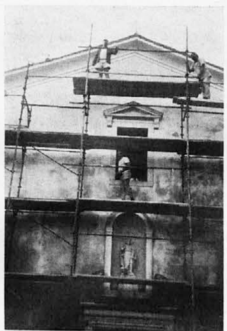
Cerkev sv. Roka v Nabrežini je ob 190-letnici svoje zgraditve dobila obnovljeno pročelje
