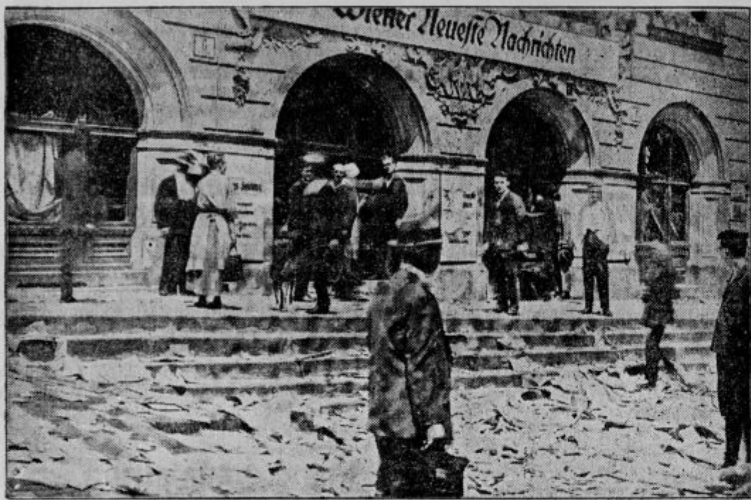
Od množice demolirano
