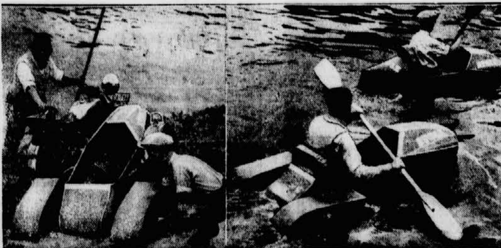
Links: Die Schwimmer werden am Beiwagen befestigt, rechts: Zwei Motorradbeiwagen mit Schwimmer als Boote im Wasser.
