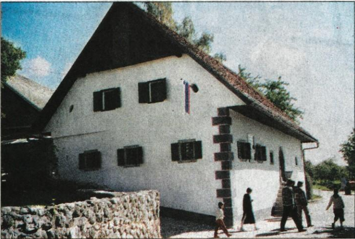
Pobarvana fasada, naslikani šivni robovi, korekcija okenskih odprtín in polkn, popravilo in zamenjava kamnitih okenskih polkn.
