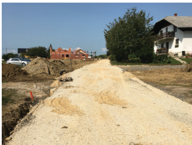
Urejanje cestnega odseka
