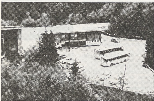
Pogled iz zraka na spodnjo postajo žičnice
