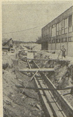
Cevovod pri novi livarni
