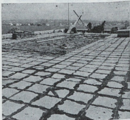
Odstranje betonskih plošč s strehe konfekcije
