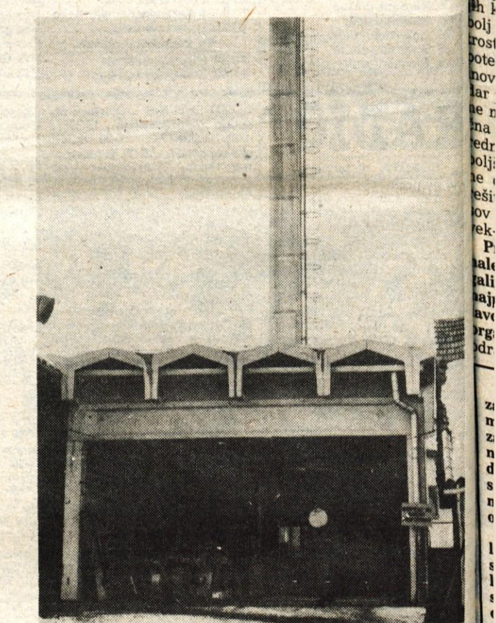
Sežigalna naprava v Stražišču — Foto: F. Perdan
