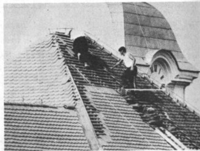
Obnovitvena dela na cerkvi sv. Martina
